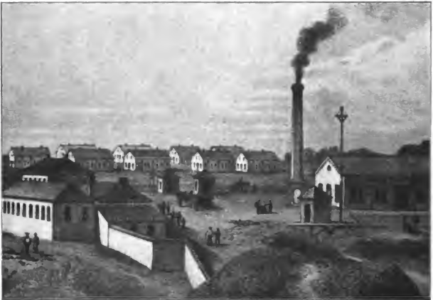
Abb. 87. Ältere Werkwohnungen (ca. 1850), Hörde.
