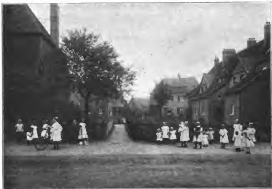
Abb. 33. Straßenteil und Durchgang. Krupsche Siedlung Margaretenhof.
